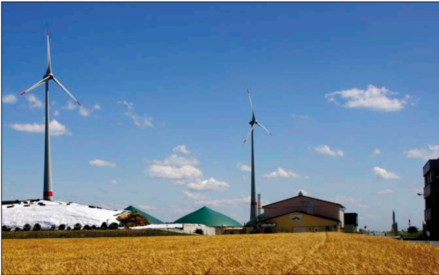
Energiedorf Mausdorf, ein Ortsteil von Emskirchen: Die Biogasanlage erzeugt Strom und Wärme. Damit werden 20 Häuser ebenso beheizt wie die Weiler Werkzeugmaschinen GmbH (rechts) und andere Gewerbebetriebe. Im Hintergrund die beiden Windkraftwerke der Reuthwind GmbH
