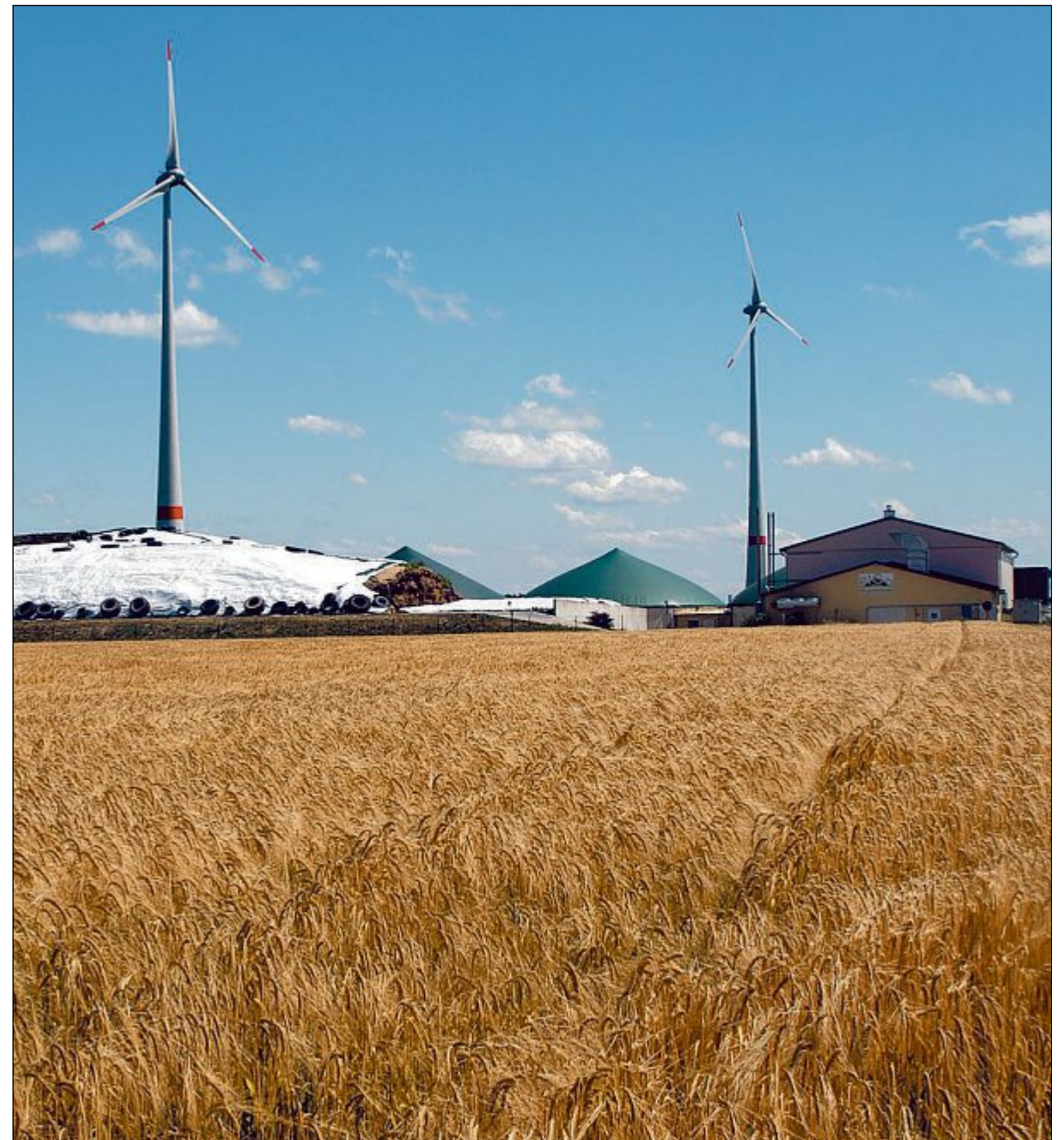
Energiedorf Maudorf, ein Ortsteil von Emskirchen: Die Biogasanlage erzeugt Strom und Wärme. Damit werden 20 Häuser ebenso beheizt wie die Weiler Werkzeugmaschinen GmbH und andere Gewerbebetriebe. Im Hintergrund die beiden Windkraftwerke der Reuthwind GmbH. FOTO WRANESCHITZ
